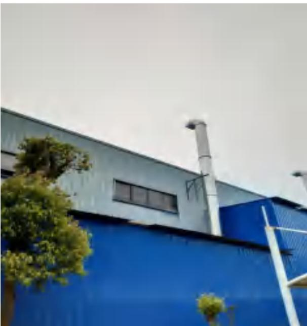
图 3-2-3 喷涂工序排气筒
