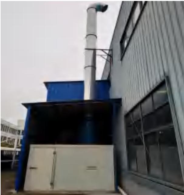
图 3-2-1 喷砂工序排气筒
