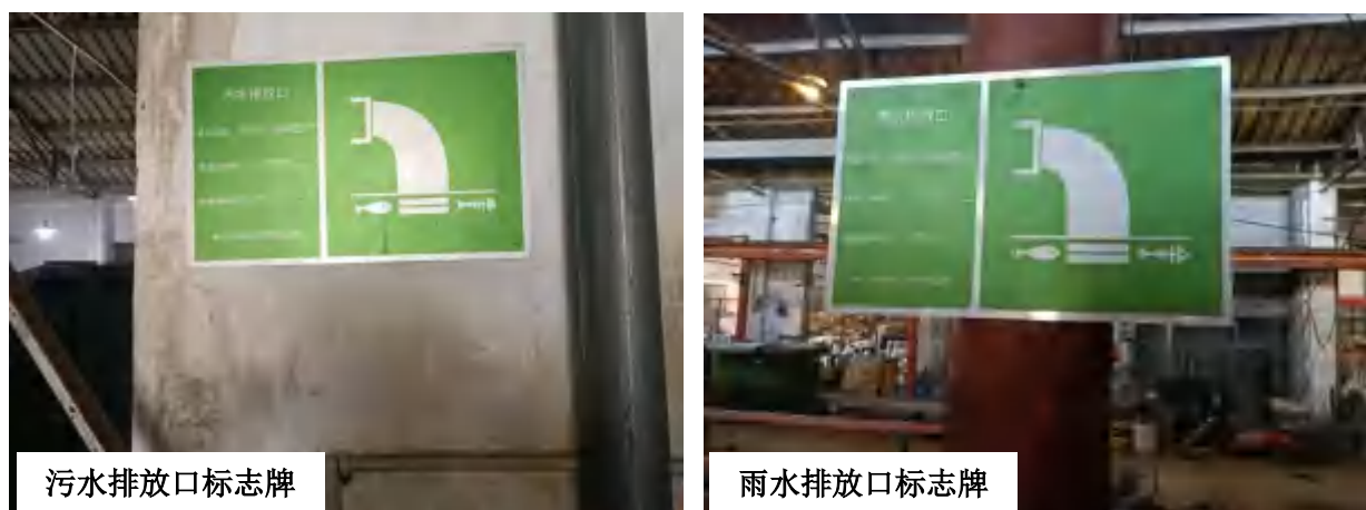
图 4-1 废水污染防治设施现场图
